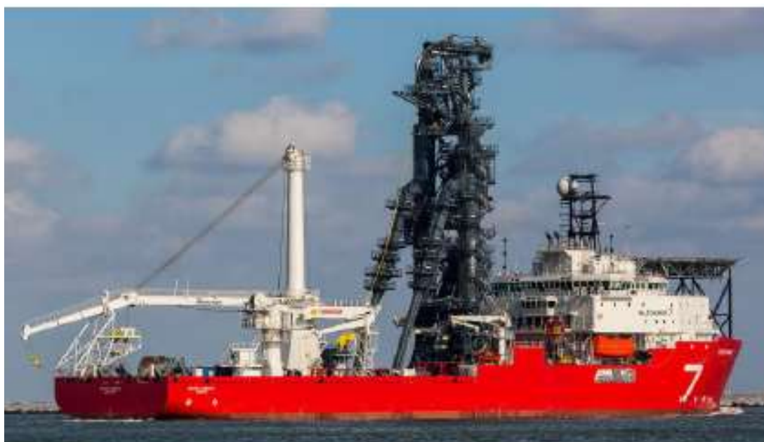
Figura 21 – Navio instalador com sistema de lançamento vertical (VLS) [16]
